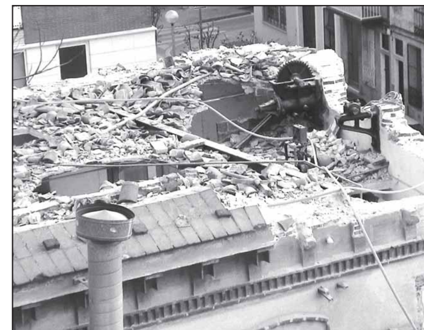
Enderroc de la nau annexa a Can Marfà.
